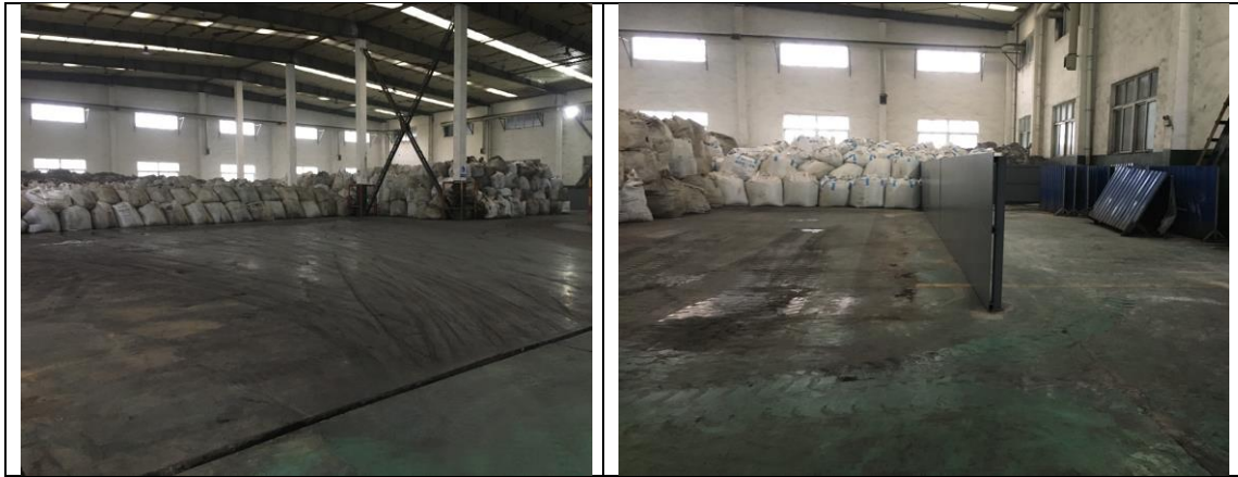
图 3.2-3 危废暂存库现场情况
