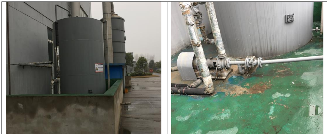
图 3.2-6 储罐区现场情况
