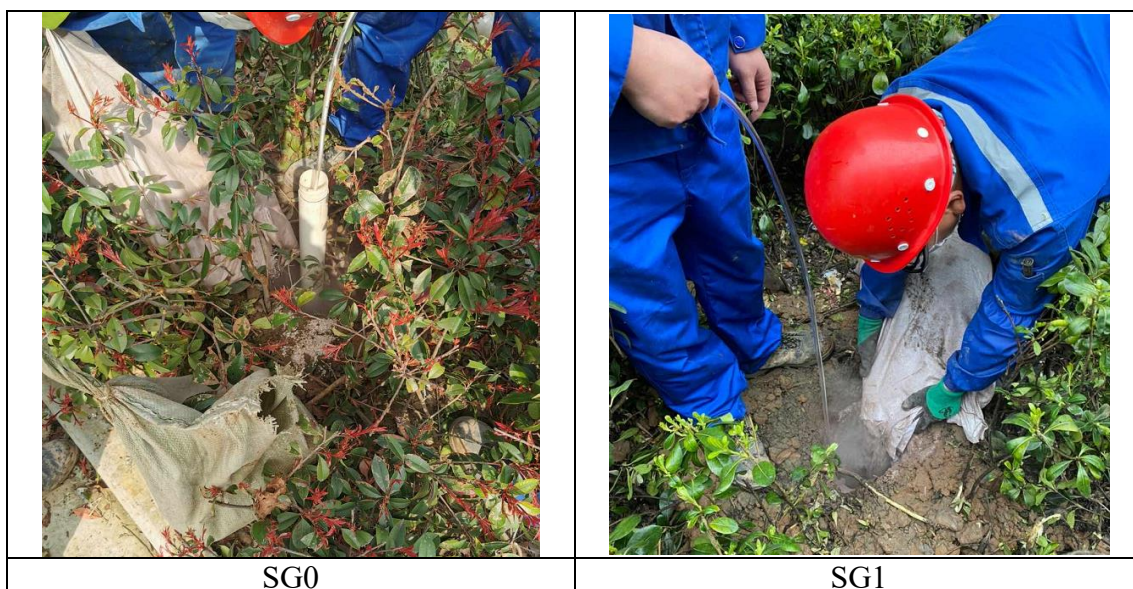
图 5.2-3 土壤气建井现场工作图
